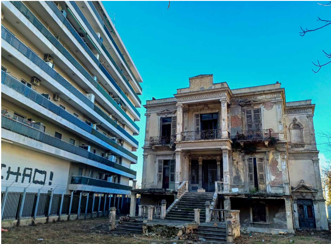
8 | Ruïne van de Salem villa en het aangrenzende flatgebouw
